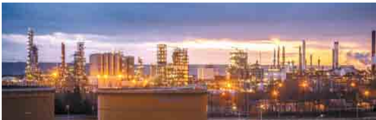
L'usine pétrochimique de Gonfreville-Lorcher au crépuscule, vue depuis la raffinerie de Normandie, France.
