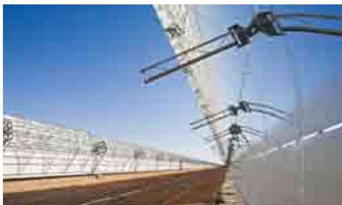
Centrale solaire à Madinat Zayed, Émirats Arabes Unis.
