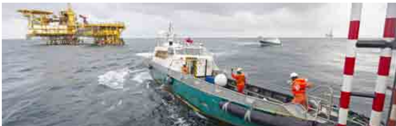
Plate-forme au large de Port Gentil, Gabon.
