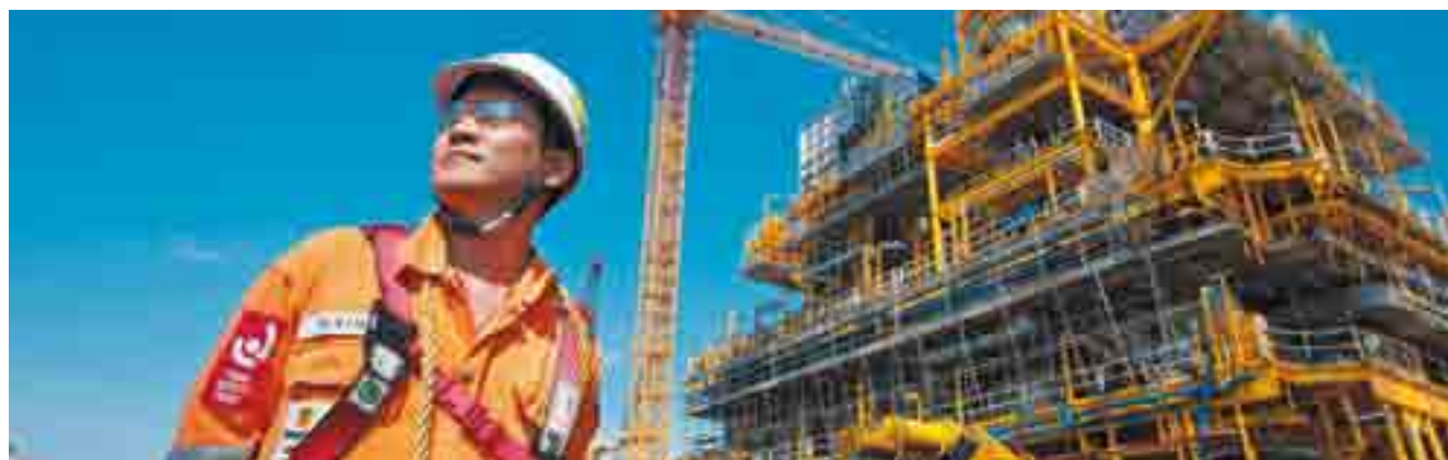
Opérateur sur le chantier d'Okpo. Projet Clov, Corée du Sud.
