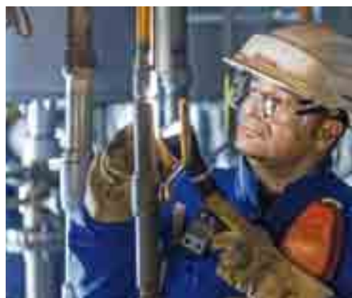
Raffinerie de Normandie, Harfleur, France.
